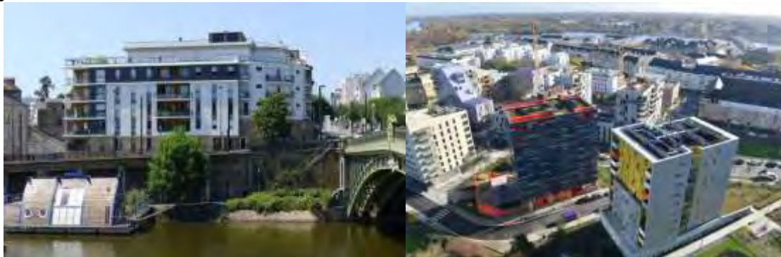
Logement social a Nantes - Ile de Nantes 2012
