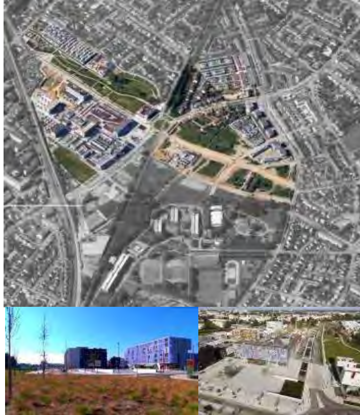
Eco quartier, Nantes : boîte à chèneaux / 2002-2018
